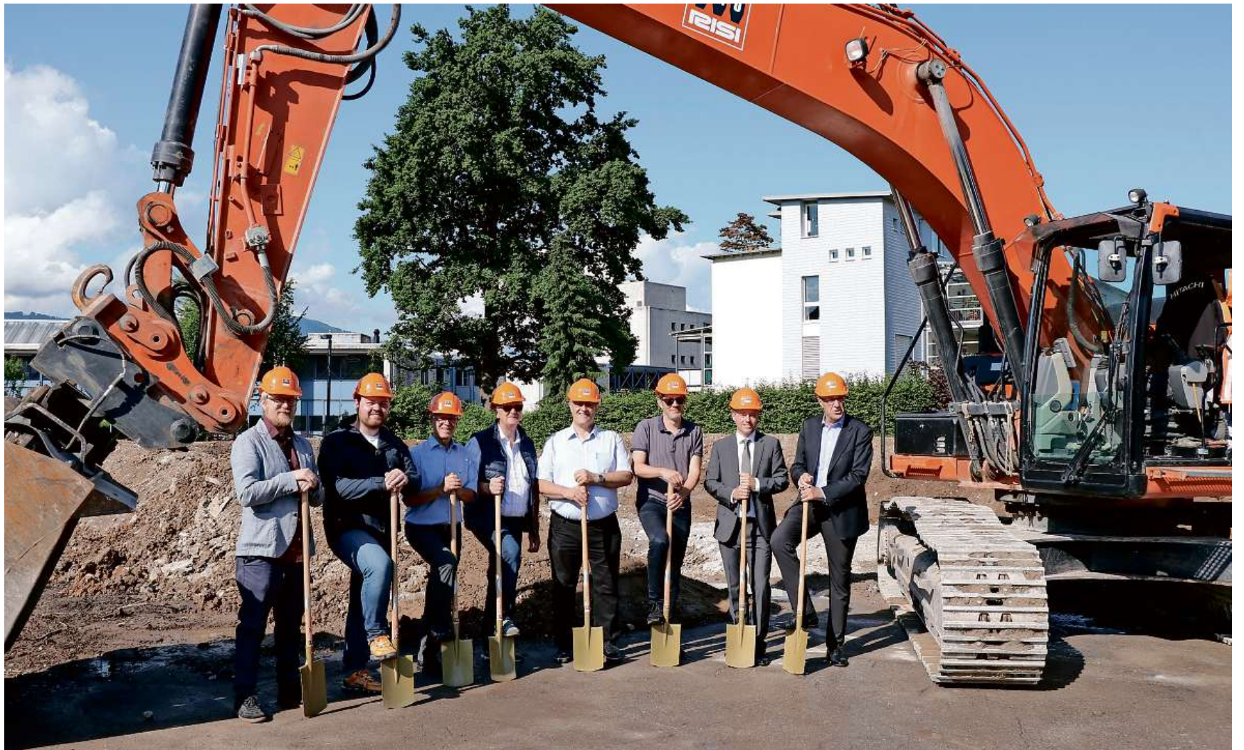
Startschuss: Erfolgreicher Spatenstich für zwei neue Mehrfamilienhäuser an der Pius-Rickenmannstrasse in Jona.
